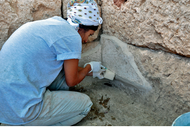
Res. 10 “Büyük Ev” harç ve duvar sıvaları konservasyonu, 2012 Fig. 10 Conservation of mortar and plaster at “Large House”, 2012
