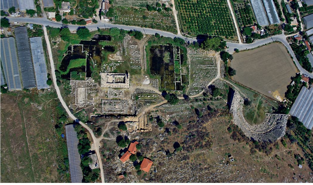
Res.1 Hava fotoğrafı, LAAP başlangıcında genel görünüm 2011 Fig. 1 Aerial photo taken at beginning of LAAP in 2011
